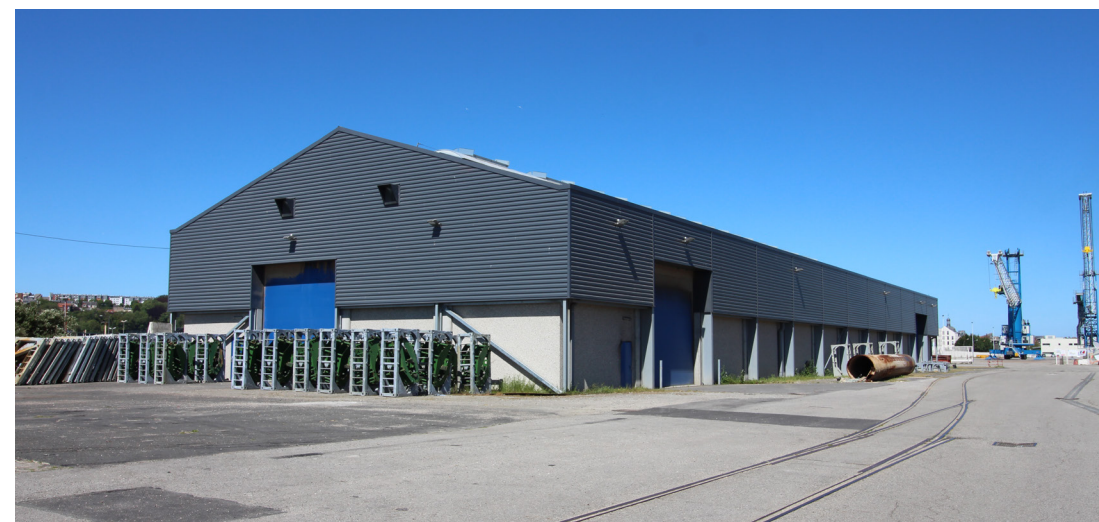
HANGAR DE STOCKAGE Dieppe 76
