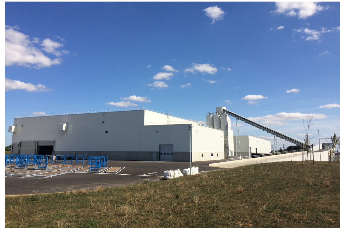
UNITÉ DE PRODUCTION D'ÉLÉMENTS BÉTON
